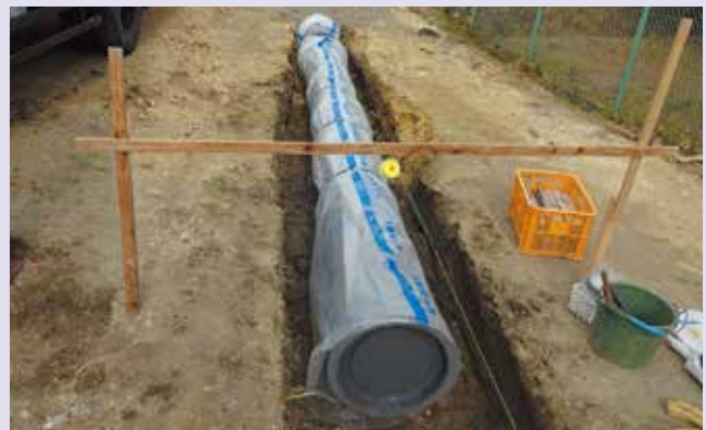
耐震管工事の様子（口径400mm）
