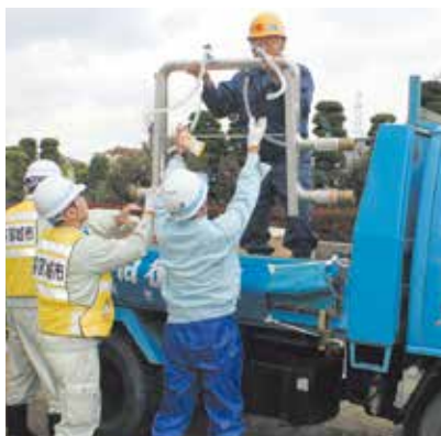
給水機材の積みこみ
