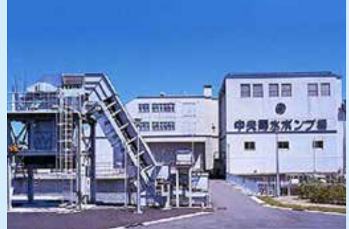
雨水ポンプ場（中央雨水ポンプ場）
