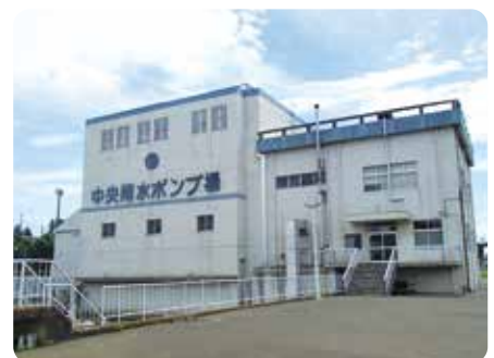
中央雨水ポンプ場 (多賀城市鶴ヶ谷一丁目)
