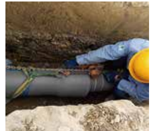
水道工事の様子
