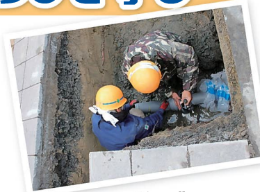
耐震管への布設替え工事の様子
