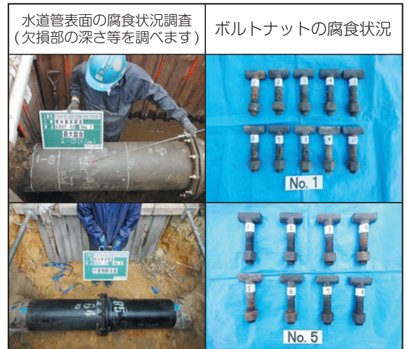
写真1：管体腐食度調査 （既存の水道管の腐食度合や配管まわりの土を採取して、管の寿命を調査します。）
