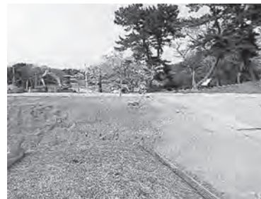
南門の盛土作業
