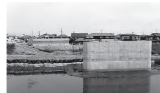
平成29年8月撮影 清水沢多賀城線整備事業
