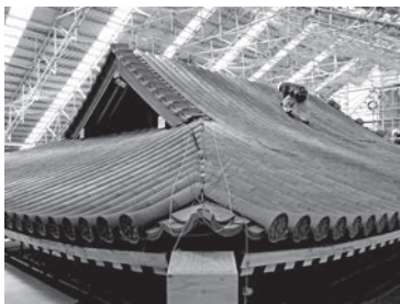
屋根先端に並んだ丸い瓦が、重弁蓮花文軒丸瓦です。
