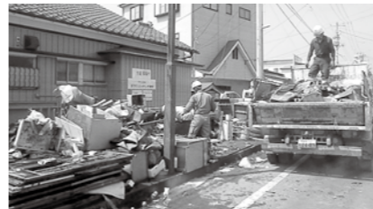
▲災害廃棄物撤去作業の様子
