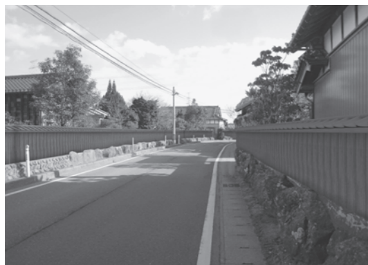
塩竈街道沿いにある住宅外構部の修繕後(板塀)のイメージ
