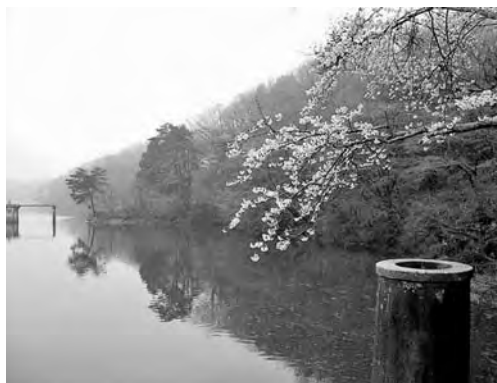
▲加瀬沼と取水塔
