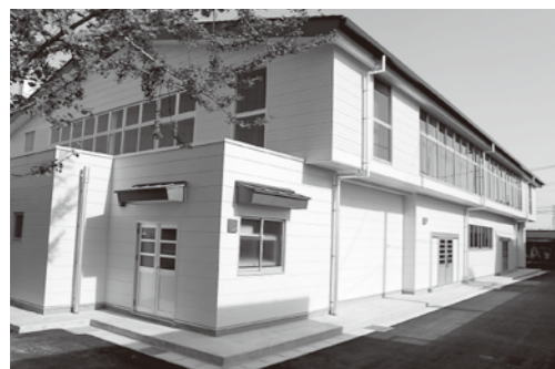
▲今年3月に新築工事が終了した山王地区公民館体育館
