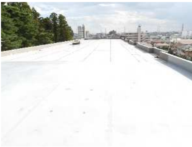
屋上 概ね良好（補修済み）
