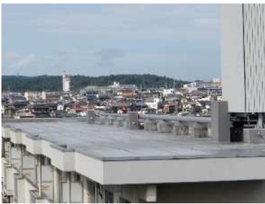
屋上 概ね良好（補修済み）
