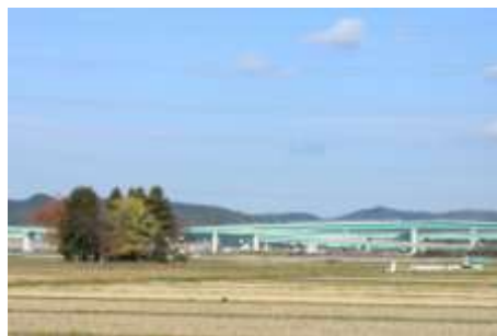
南宮神社と三陸縦貫自動車道
