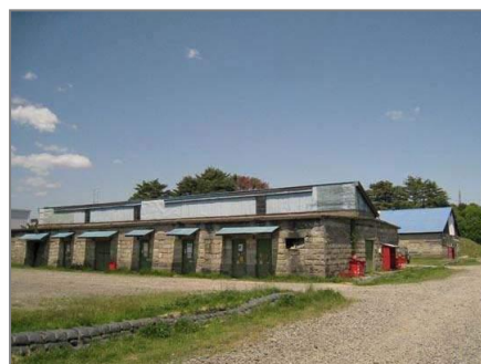
海軍工廠時代の建造物 （多賀城駐屯地内）
