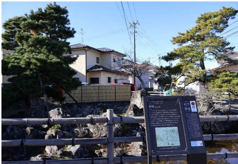
興井の清掃作業後の状況
