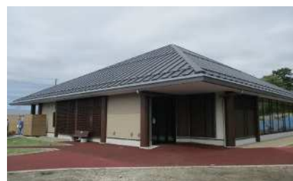
トイレ及びガイダンス施設整備
