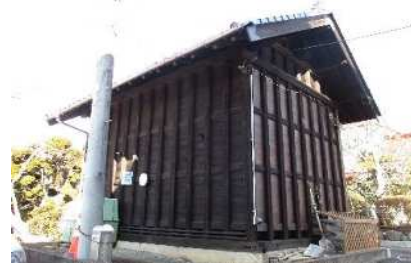
板倉改修後の様子 R4. 2
