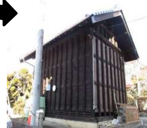
板倉改修後の様子
