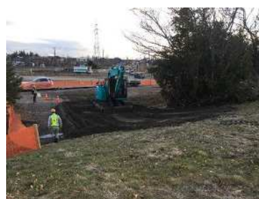
南門復元工事の様子
