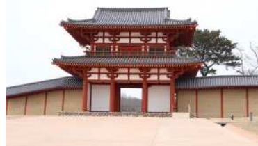
多賀城南門建築 工事完了状況（R7）
