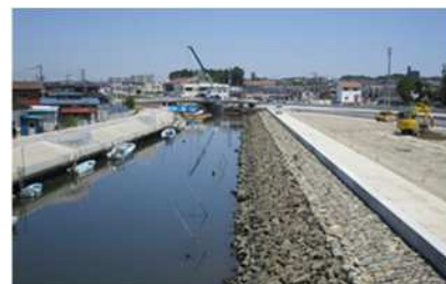
護岸修復完成後の様子
