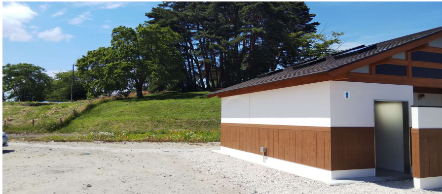
特別史跡の景観に配慮した公園トイレ
