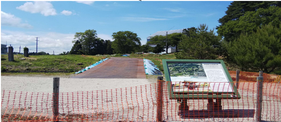
施工ヤードとして活用している南北大路予定箇所
