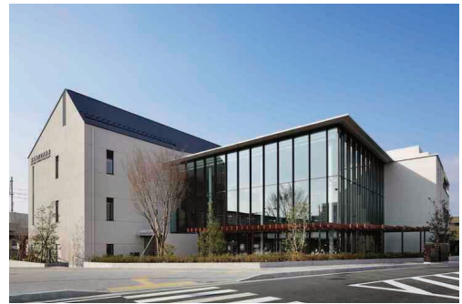
▲多賀城市立図書館
