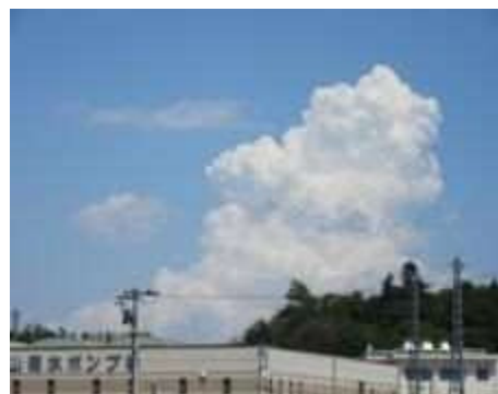
丸山ポンプ場上空です
