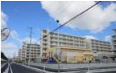
1号棟側から見た全景
