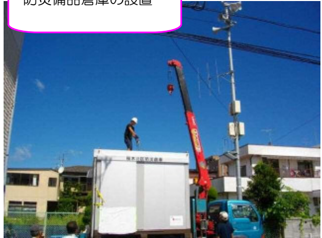
防災備品倉庫の設置
