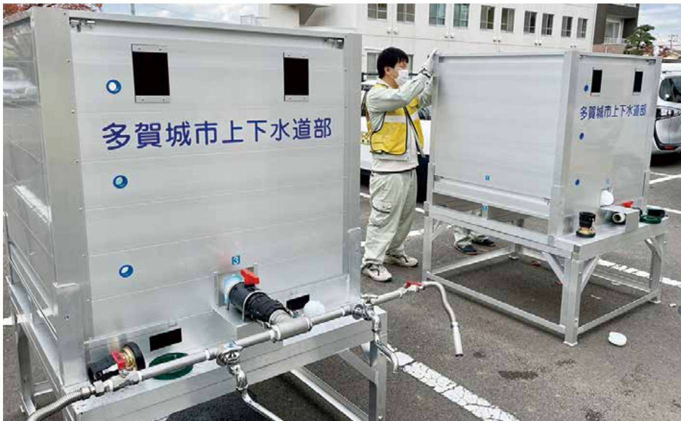
訓練で設置した応急給水タンク
