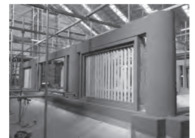
二重柱の組立状況
