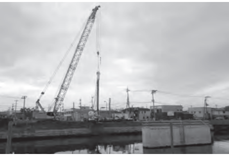
9月7日撮影 笠神八幡線 橋梁下部工工事
