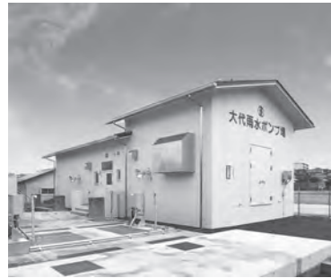
8月4日撮影 大代雨水ポンプ場
