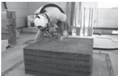
▲版築試験施工の様子
