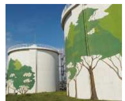
天の山配水池
