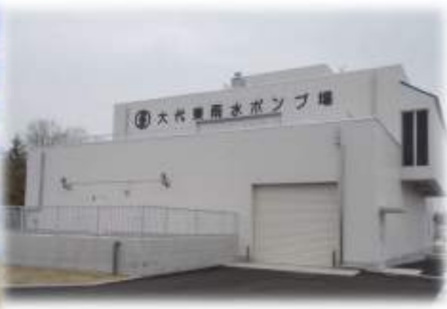
大代東雨水ポンプ場
