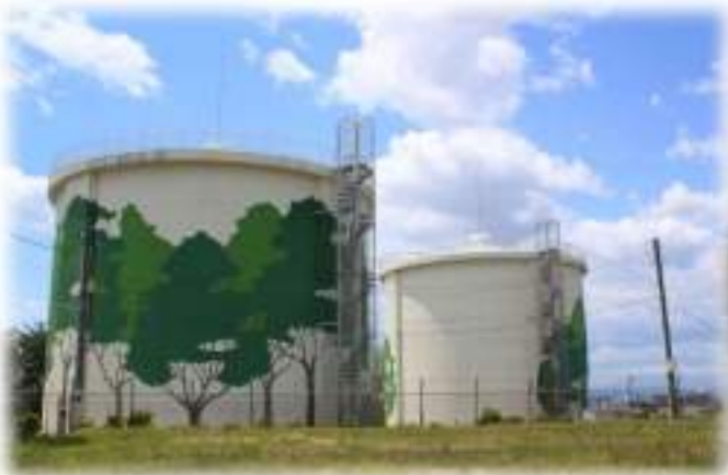
天の山配水池
