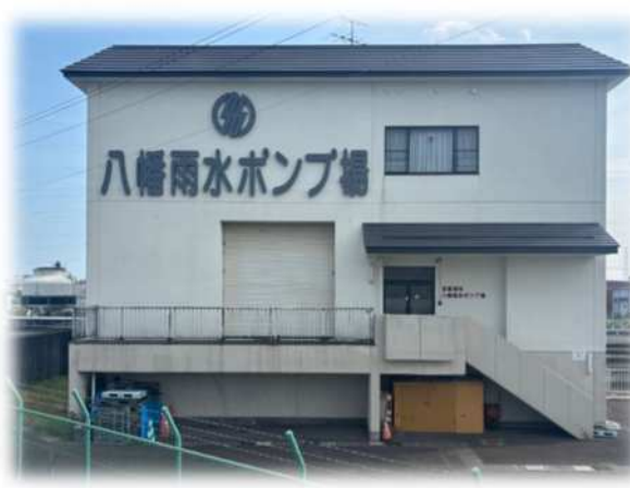
八幡雨水ポンプ場
