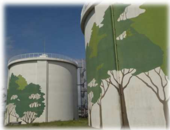
天の山配水池
