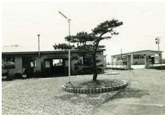
左：末の松山配水場(昭和47年)
