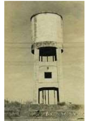
右：旭ヶ岡高架水槽
