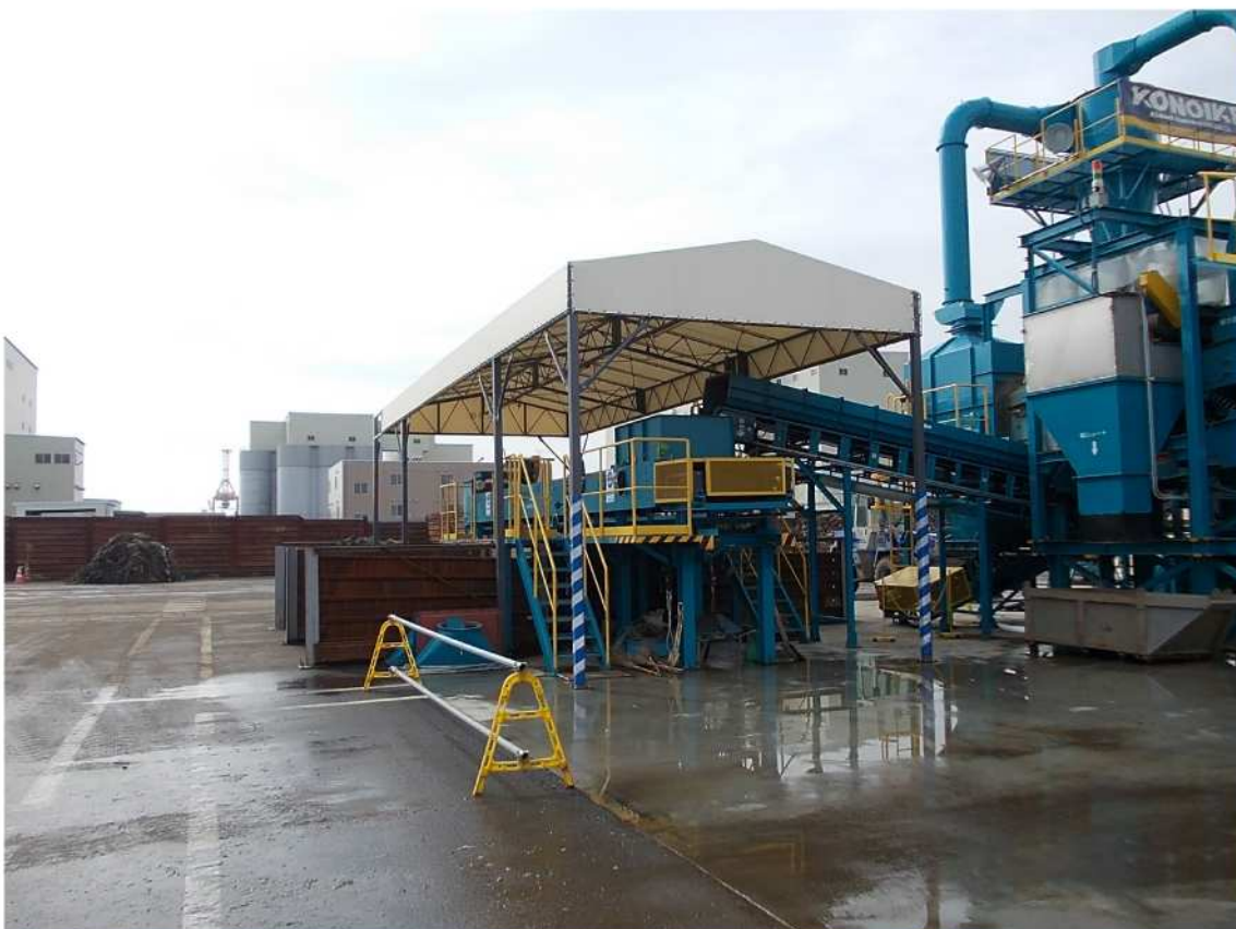
分別機で、集積された災害ごみを木材をはじめ、土砂、鉄くずなどに分別します。
