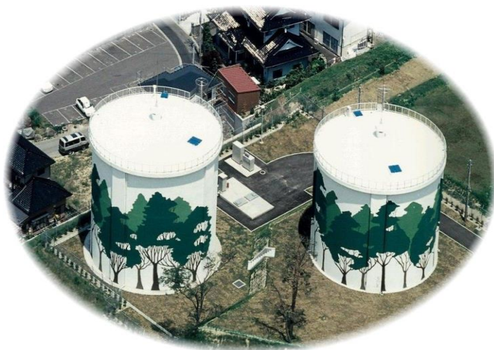
天の山配水池
