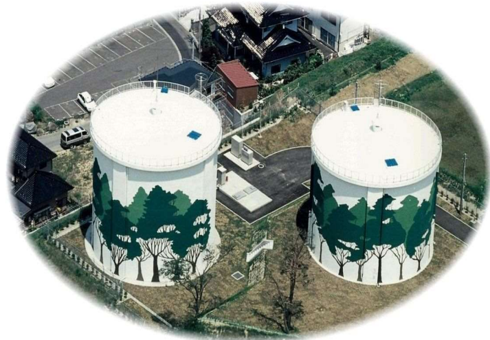
天の山配水池
