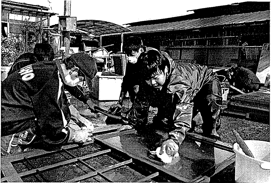
被災した民家の建具を洗浄する鹿島台商高生＝26日午前10時30分ごろ、大崎市鹿島台下志田
