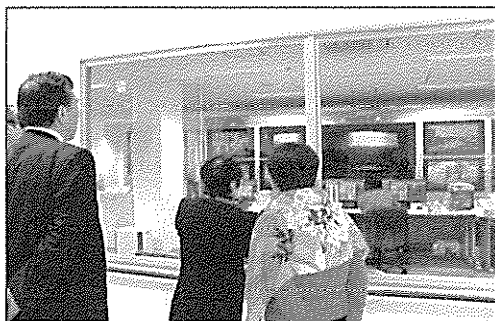
④ 中央制御室
