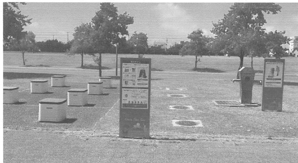
防災トイレと手押しポンプ(防災井戸)
