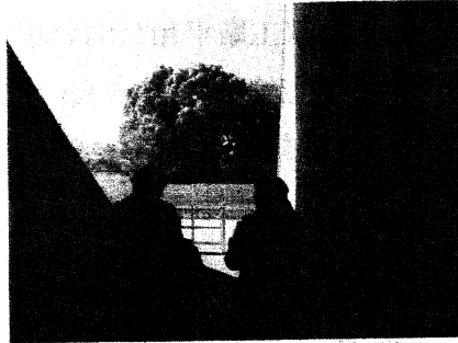
⑧通路から西方を望む。名大研究所跡に、同様の火薬庫跡が残されている。向きがこちらと直角につくられている。爆風防止のためとのこと。
