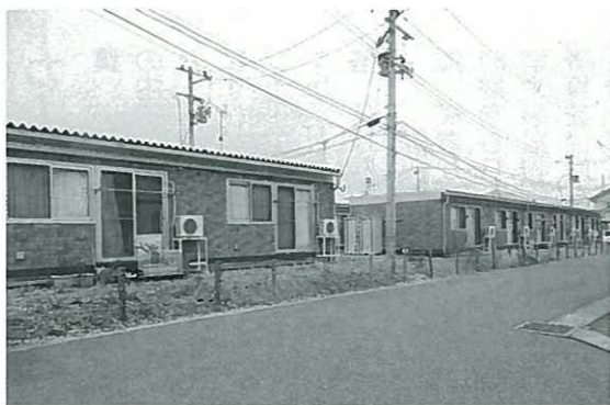
高橋仮設住宅
