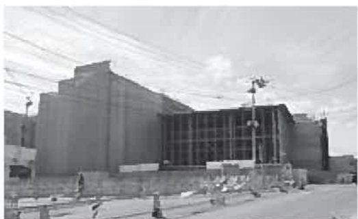
工事は着々とすすんではいますが…
