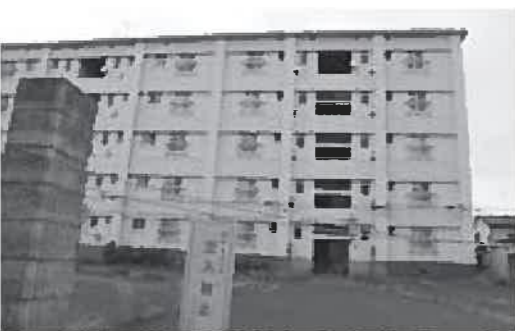
閉鎖された仙台防衛施設局多賀城宿舍
