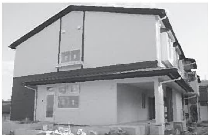
建設中の特養ホーム(伝上山地区)
