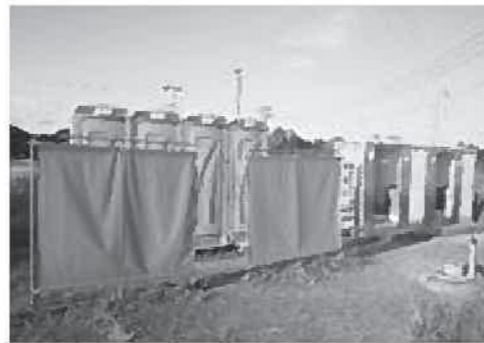
中央公園の仮設トイレ
