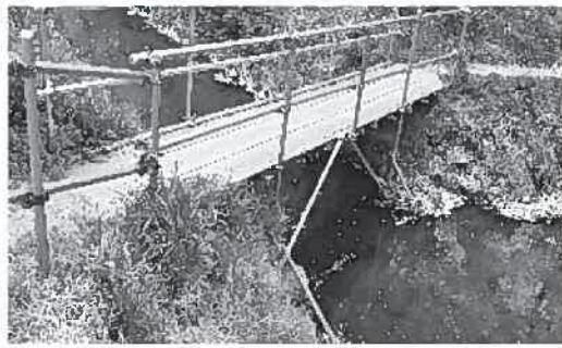
鉄パイプでできた暫定的な橋
