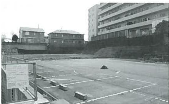
今年度中に完成予定の福祉施設建設予定地(伝上山)
