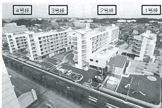
平成26年10月に完成した桜木地区災害公営住宅
