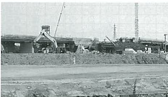
(仮称) 多賀城インターチェンジ工事風景 (市川地区)
