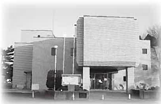
多賀城市立図書館
