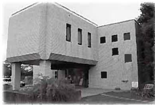
多賀城市立図書館
