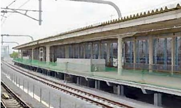
建設中の下りホーム
