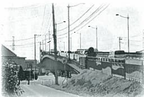
耐震化工事予定の樋の口大橋
