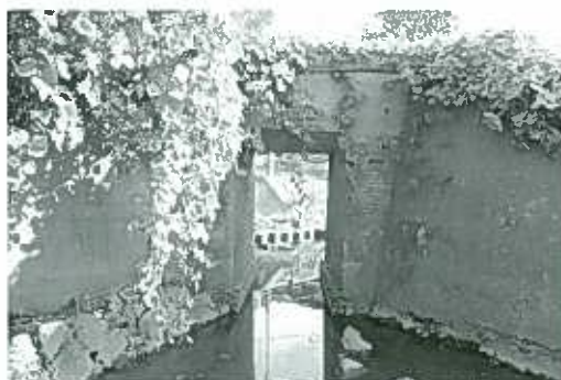
旧JR塩釜線のレンガ橋。バイパスを設け流下能力の拡大を。
