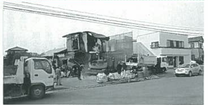
解体中の住宅(栄地区)
