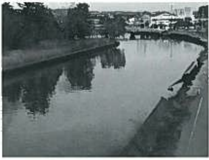
護岸が崩れた貞山運河
