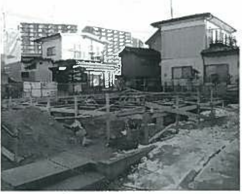
進む住宅の再建、改修工事
