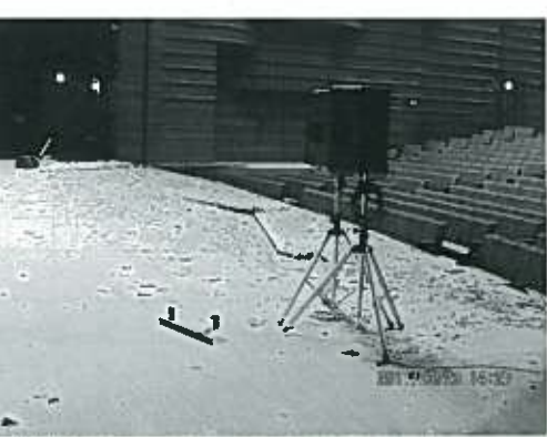
被災した文化センター大ホール
