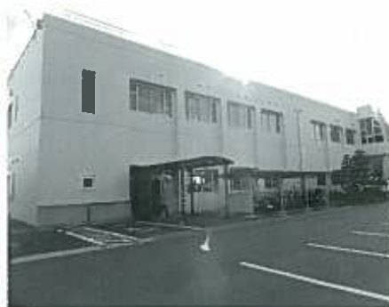
上水道部の庁舎
