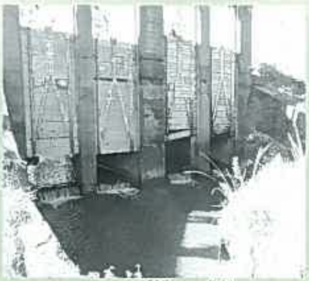
▲砂押川庚田排水樋門
