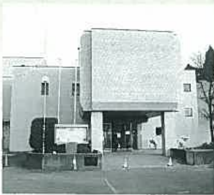
▲多賀城市立図書館
